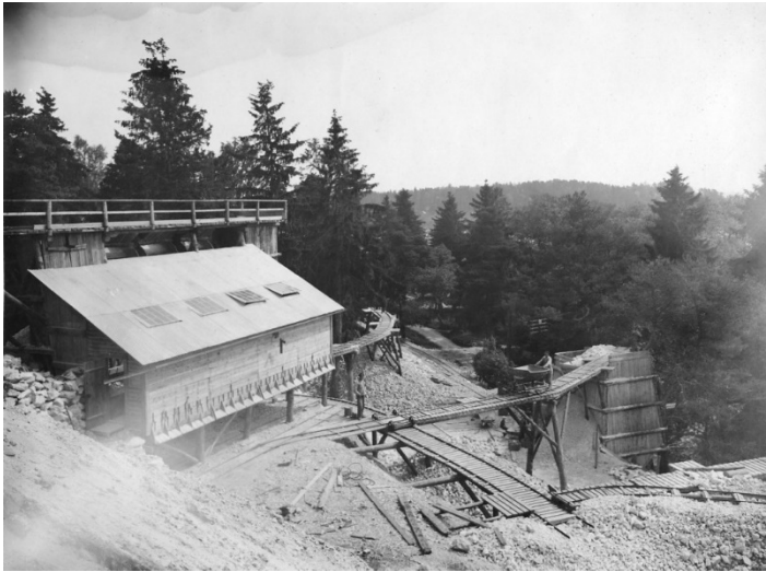
Figura 8. A mina de Ytterby en 1910.
